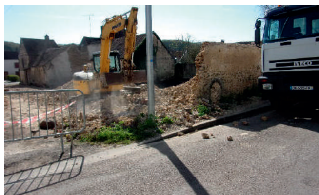
Fin des travaux de démolition en avril 2015
