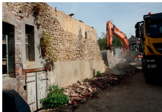
La démolition de la 1ère partie peut commencer
