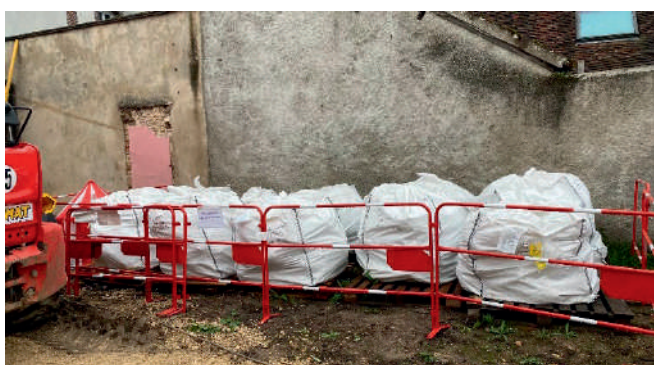
Les bigbags de déchets amiantés et plombés
