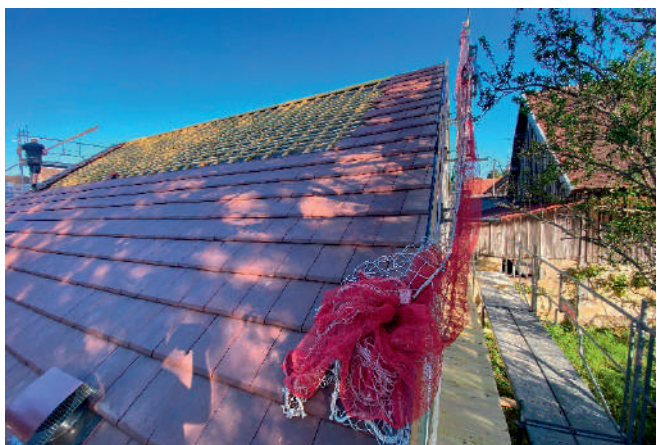
La pose des tuiles traditionnelles « côté voisins » est terminée
