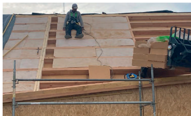
Pose de l'isolant en laine de bois (2 fois 16 cm)
