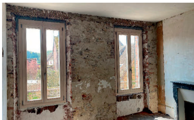
Les fenêtres sont mises en place
