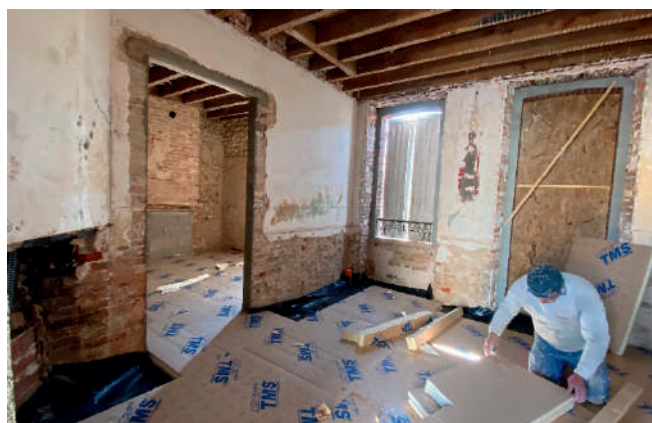
Pose de l'isolant au sol du rez-de-chaussée
