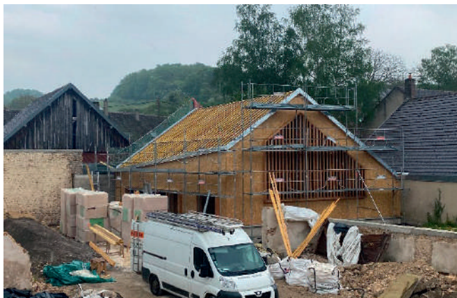
Les liteaux de maintien des tuiles sont posés
