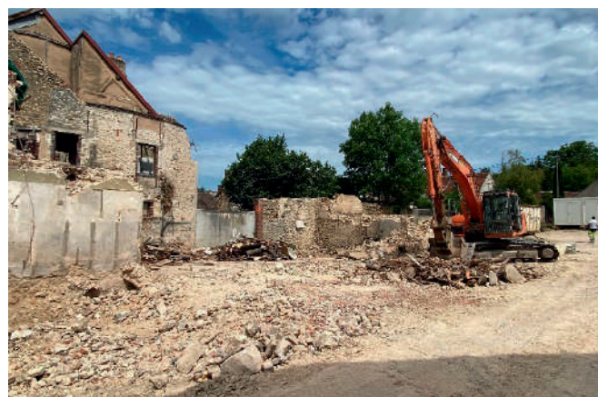
La première étape de démolition se termine
