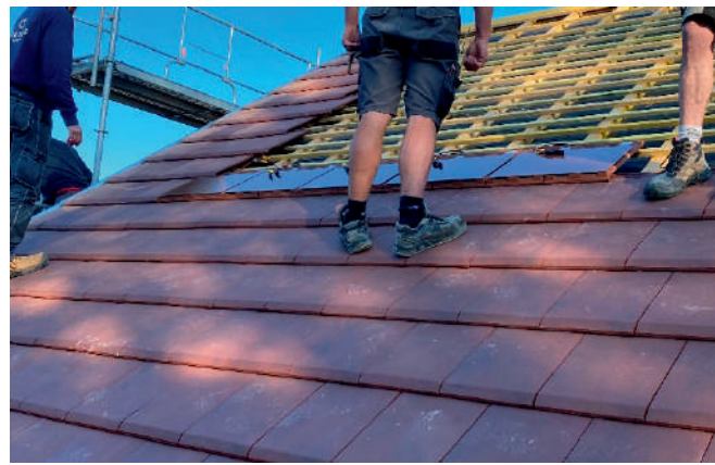
Début de la pose des tuiles photovoltaïques
