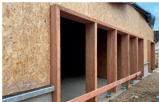
Vue de la façade « côté cour »
