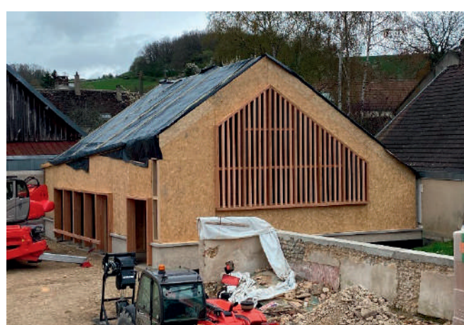
L'ensemble est monté et protégé de la pluie
