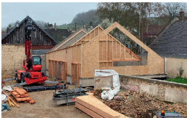
La structure bois principale est montée
