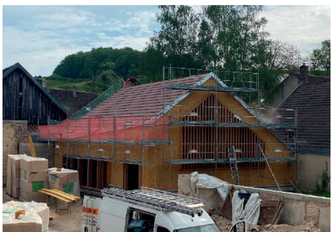
La couverture « côté cour » est terminée
