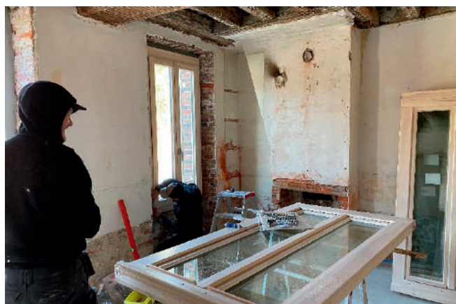
Préparation des fenêtres avant d'être posées
