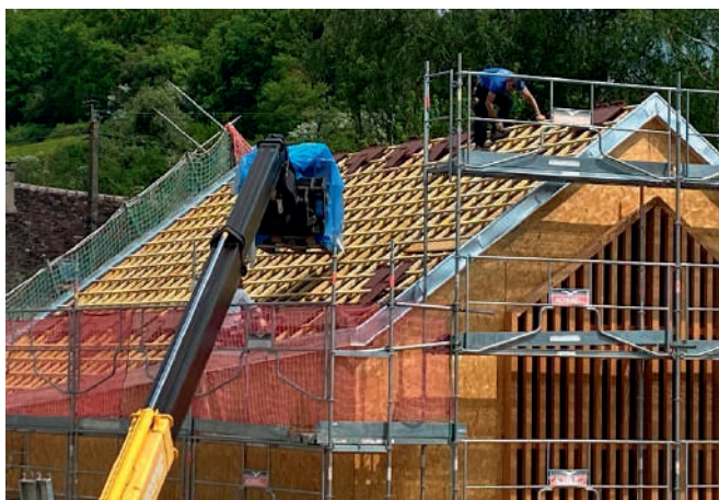
Début de la pose des tuiles « côté cour »
