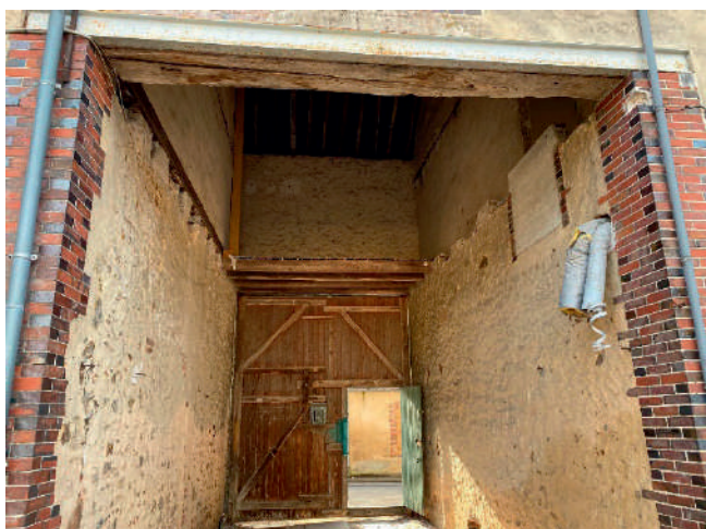
Le plancher du porche a été enlevé
