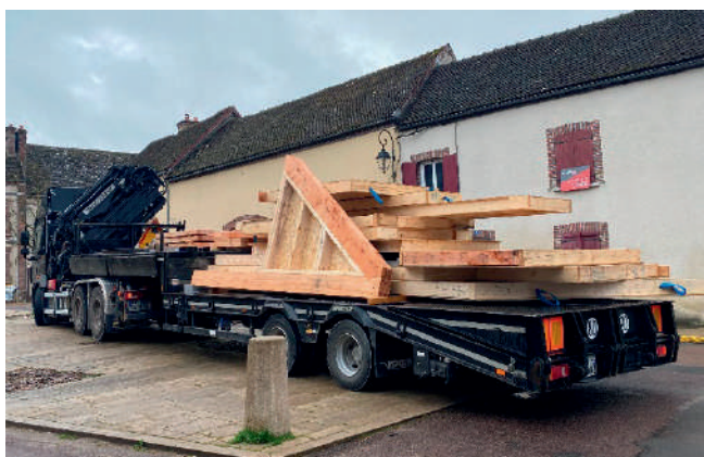
Arrivée des premiers éléments de l'ossature bois
