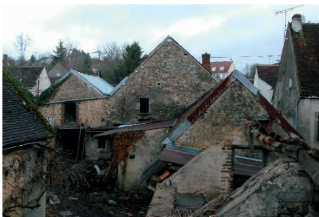
Un ensemble de bâtiments insalubres
