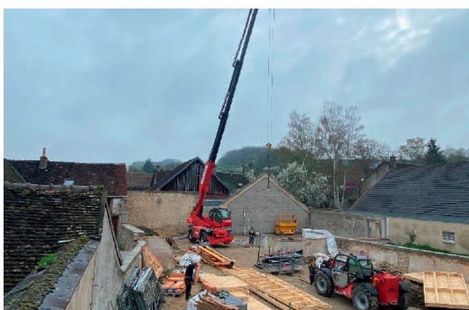
Mise en place du matériel de levage
