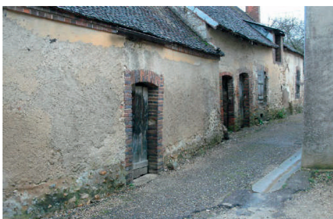
Et comme cela, vue de la rue des Taillandiers
