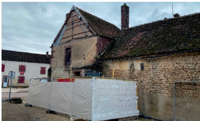
En février 2022, désamiantage des bâtiments
