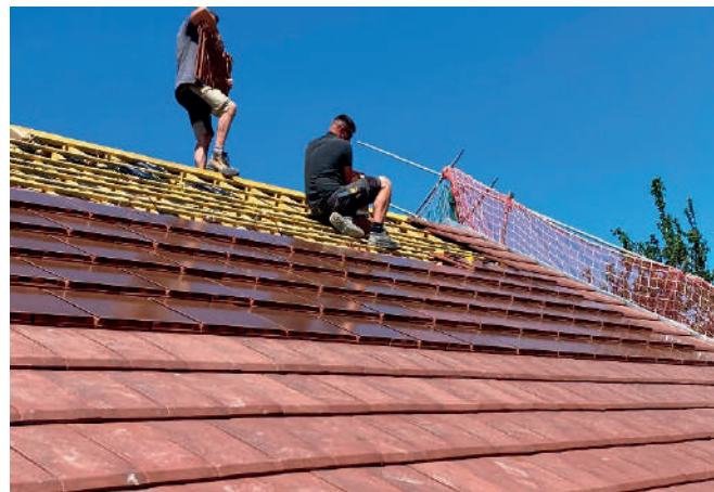
6 rangées de 20 tuiles de 24 Wc sont posées Soit une capacité productive de 2880 Watt/crête
