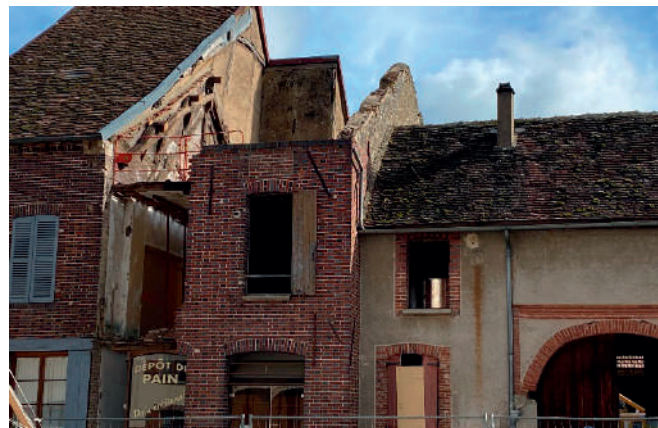
Le désaccouplage avec la maison du voisin est effectué manuellement
