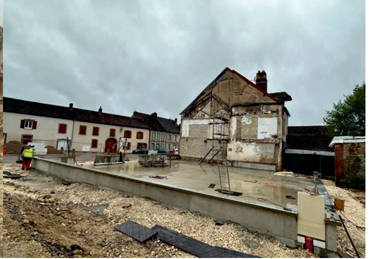
Les poutres sont posées, la dalle est coulée, les murs de soutien également, le pignon du fond est en cours.
