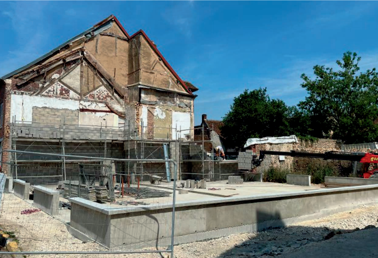
Les poutres sont posées, la dalle est coulée, les murs de soutien également, le pignon du fond est en cours.
