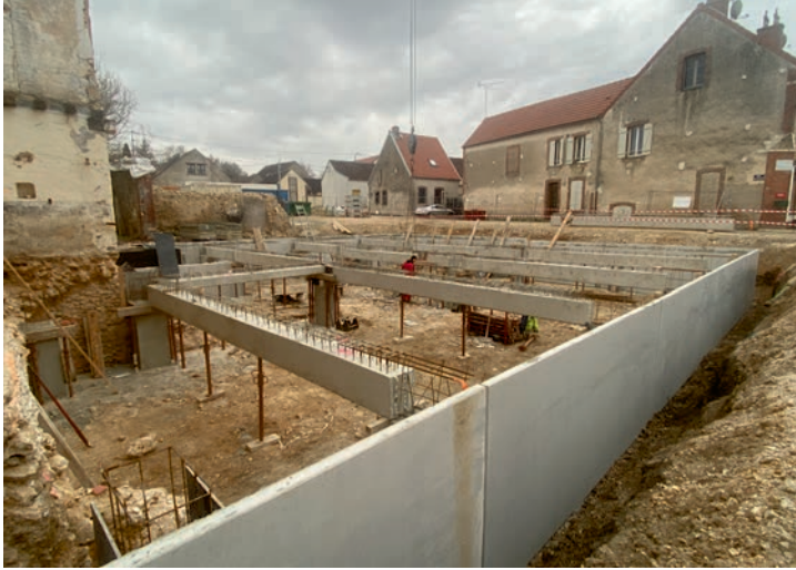
Les poutres sont posées, la dalle est coulée, les murs de soutien également, le pignon du fond est en cours.
