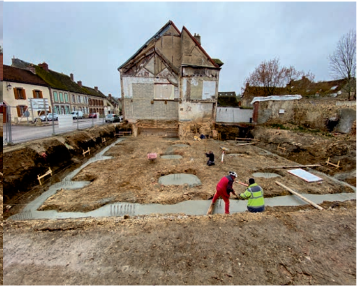
En haut, les fondations sont coulées.
