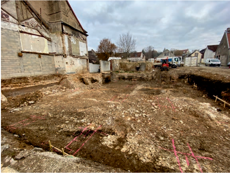
En haut, traçage dans le fond de forme.
