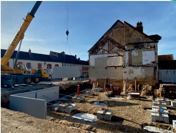
En bas, coulage des poteaux de maintien.
