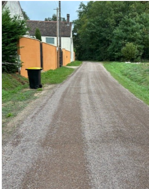
Route de Vaumartin avec décapage de bords de route
