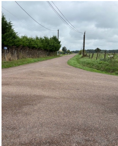
Route de Grange Pourrain à la Poste aux Ânes avec décapage de bords de route
