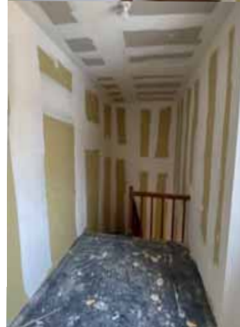
En haut : Escalier d'accès à l'étage Vue du palier
