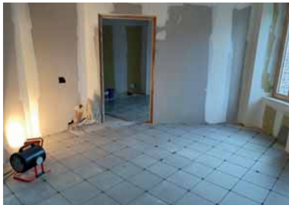
La pose du carrelage
