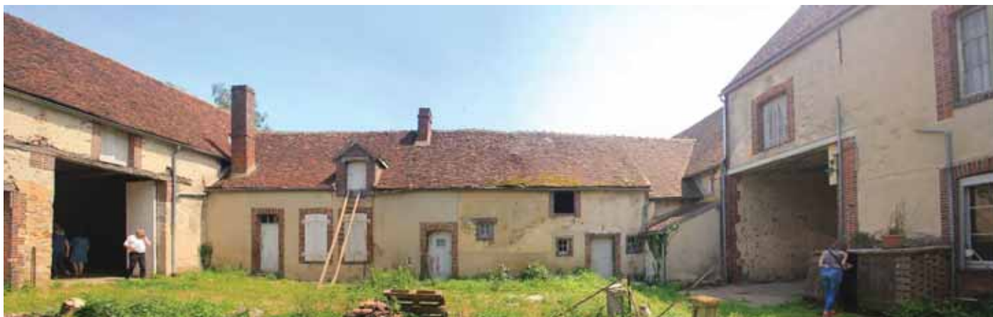
Vue de l'état actuel de la cour. La maison en fond et les granges à gauche seront démolies.
