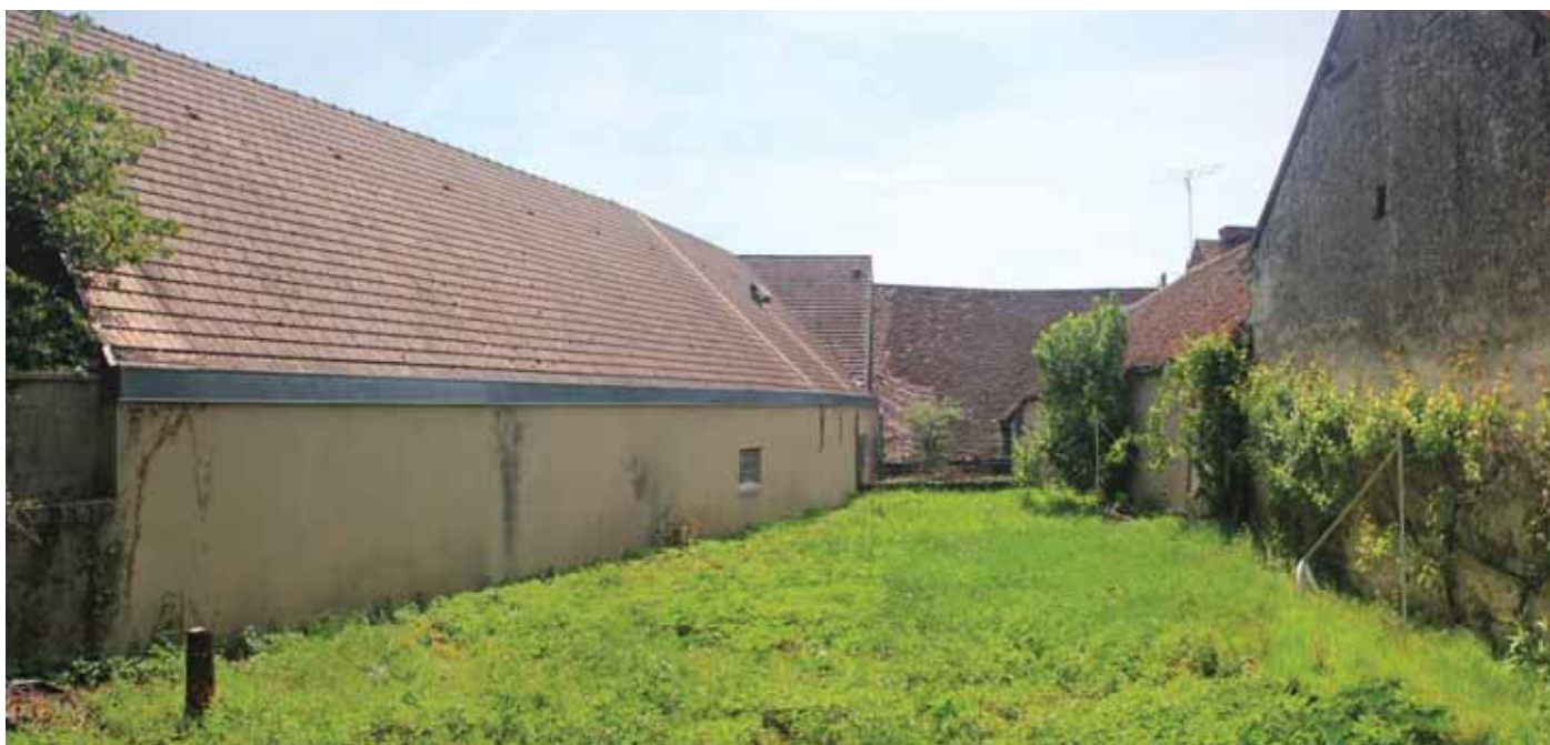
Vue de l'état actuel de l'arrière-cour donnant sur l'école. La grange et la maison à droite seront démolies.
