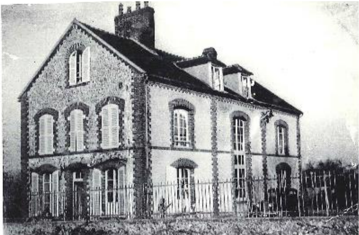
Imposant bâtiment de l'école de la Borde à-la-Gousse desservant ce gros hameau et les écarts du Nord-Est de la Commune (photo 1950)
