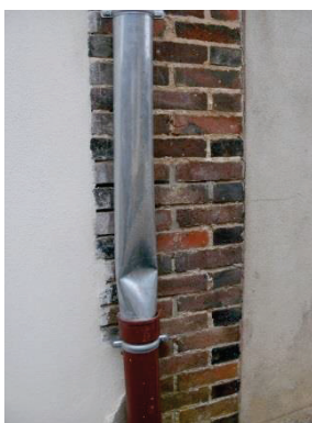
Gouttière endommagée
